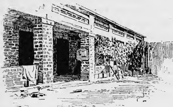
UN BUREAU DE POSTE (KITA).
